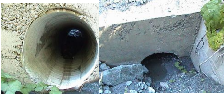
Şekil 4. Büzün mansap kısmına ait bir görüntü, büzün menba kısmında baş duvarın görülmesi
