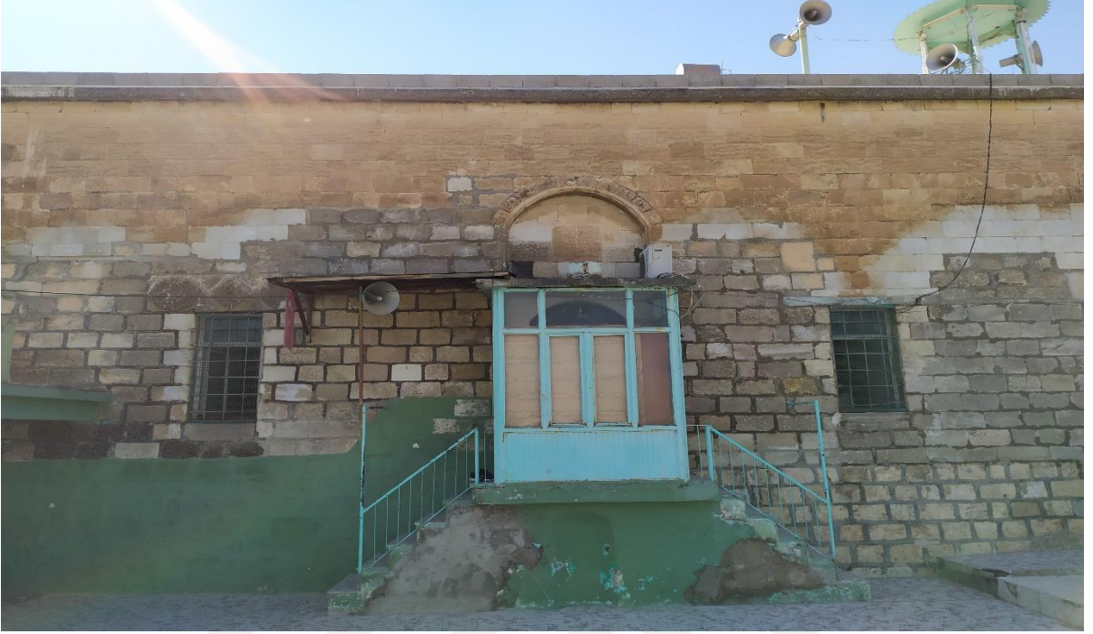
Fotoğraf 19: Sancak Mahallesi Mescidi Genel Görünüm
