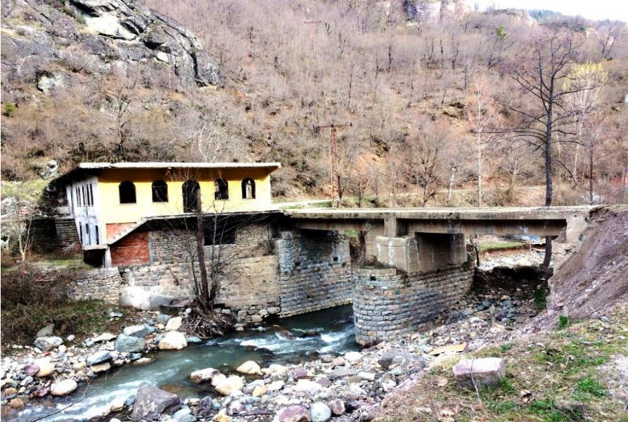
Hacıpaşa Köprüsü'nün kuzeyden görünümü ve yapılan restoran.
