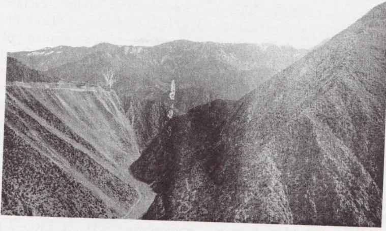
Şekil 1: Çoruh Nehrinde yüksek kotta yapılan yollar havzada önemli oranda erozyona neden olmaktadır
