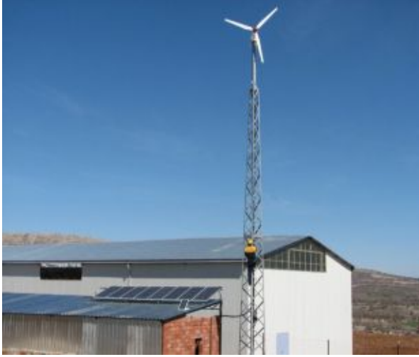
Resim 1. Rüzgar ve güneş enerjisinin, ev ve işyerlerinde birlikte kurulumu ve kullanımı (Melez Sistem)
