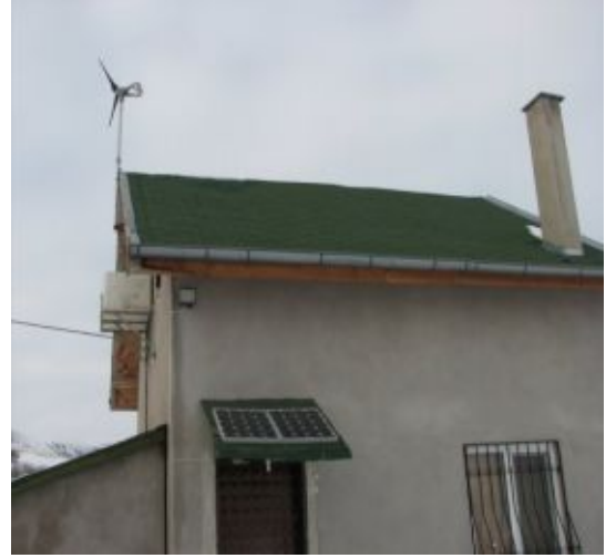
Resim 1. Rüzgar ve güneş enerjisinin, ev ve işyerlerinde birlikte kurulumu ve kullanımı (Melez Sistem)
