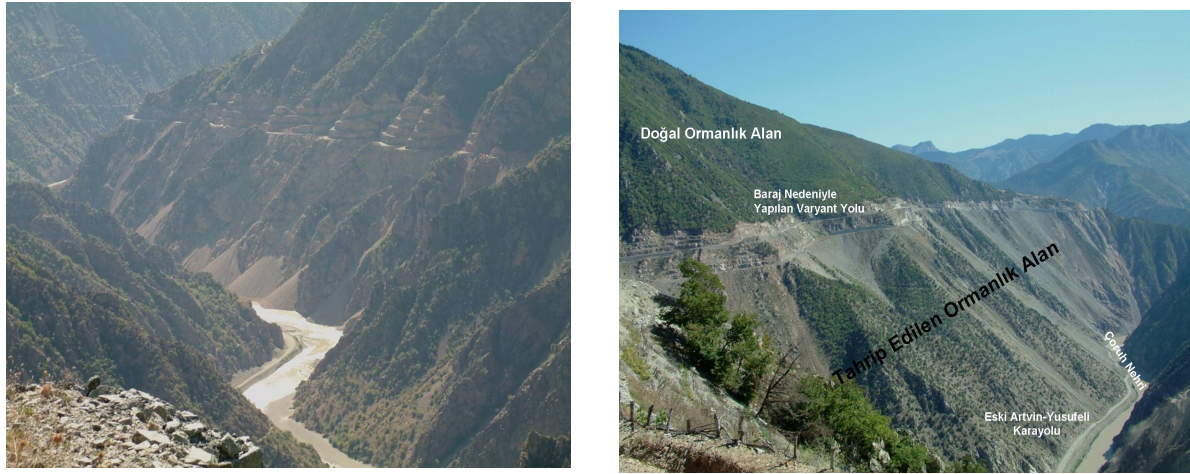
Şekil 6. Deriner Barajı nedeniyle kullanılamaz hale gelen eski Artvin-Yusufeli-Erzurum karayolu yerine yapılan varyant yolu ve yeni Artvin-Erzurum yolunun inşası sırasında ortaya çıkan hafriyatın şevlerden aşağı atılması ile zarar gören bitki örtüsü ve su kaynağı.
