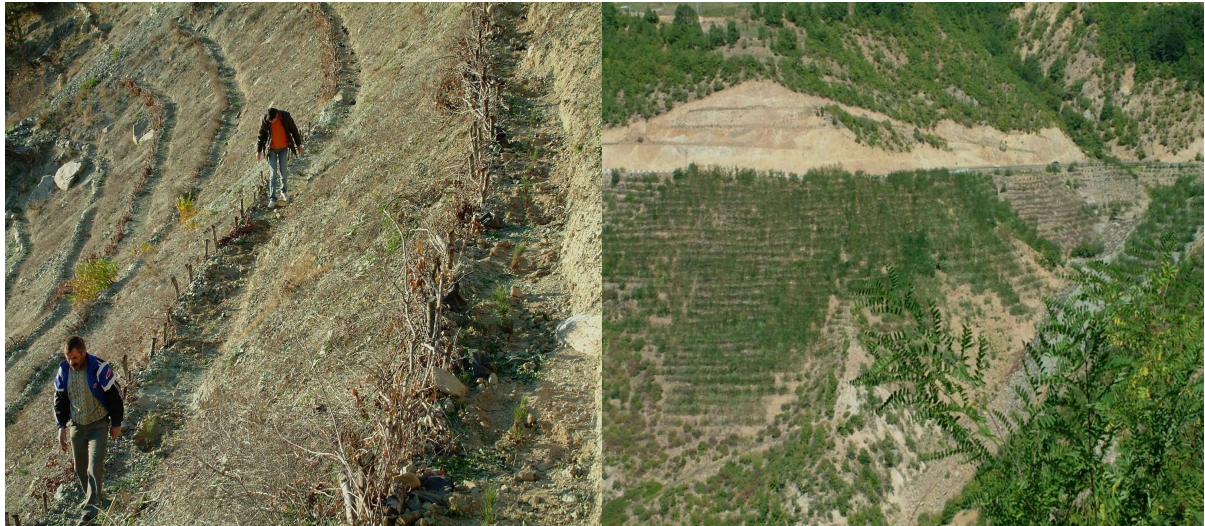
Şekil 8. Salkımlı Köyü yakınlarında yol yapımından etkilenen alanda yapılan erozyon kontrol amaçlı çalışmalar
