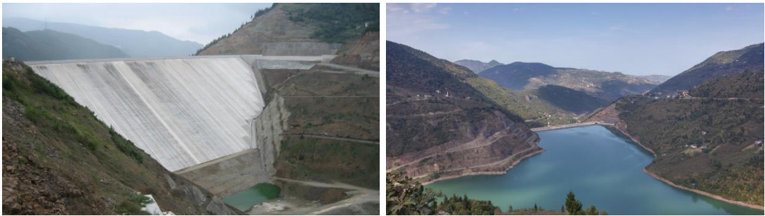
Şekil 3. Atasu Barajı, Trabzon (rezervuarın boş ve dolu durumları)
