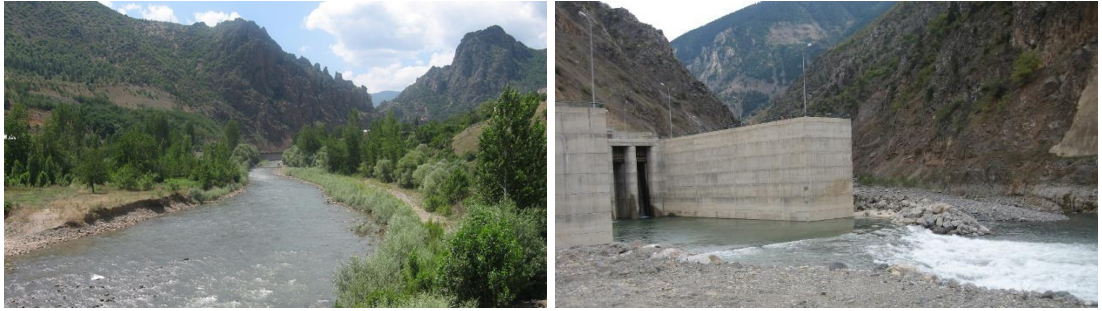
Şekil 2. Torul Baraj Gölü memba ve mansabında seçilen su kalitesi gözlem istasyonları
