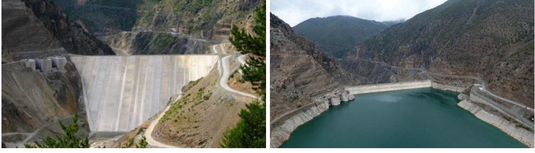
Şekil 1. Torul Barajı, Gümüşhane (rezervuarın boş ve dolu durumları)
