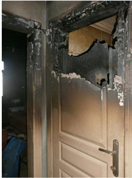
Şekil 6. Ahşap kapı doğramasında yangın ile meydana gelen kömürleşme (Bekem Kara, 2012).
