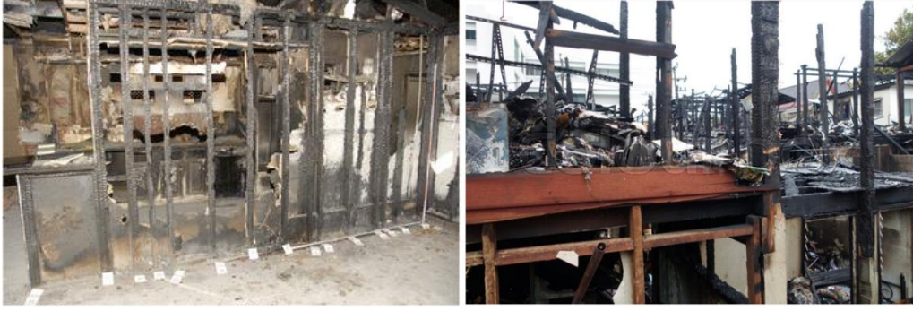
Şekil 9. Ahşap taşıyıcı elemanlarda kömürleşme (Gorbet vd., 2015; URL-1, 2025).
