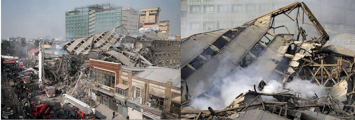
Şekil 8. Plasco Binası enkazı (Taherkenareh, 2017).
